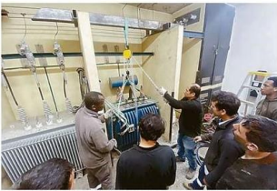
RENOVACIÓN NECESARIA ANTE LLEGADA DE EQUIPOS MÁS MODERNOS.
